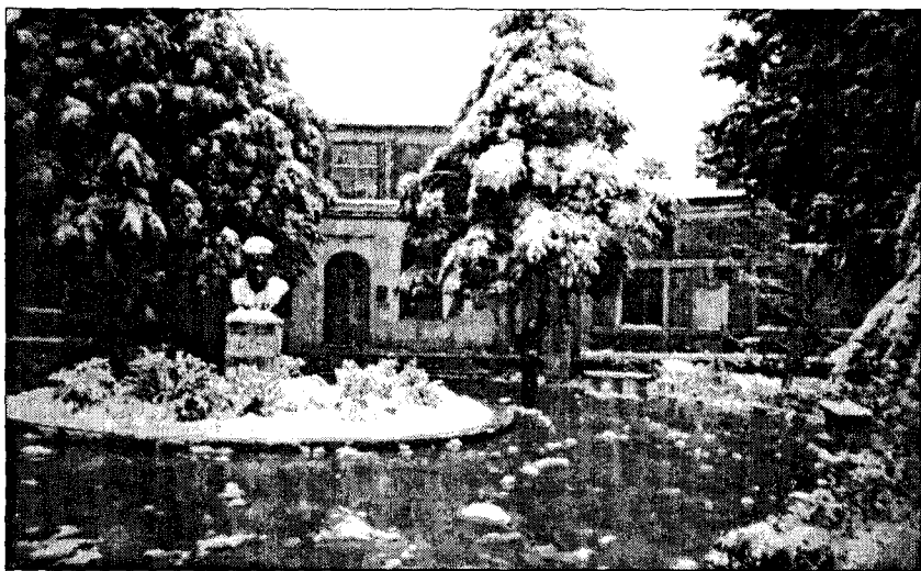
Şəkil 1. Azərbaycan MEA Mərkəzi Nəbatat Bağının inzibati binası
