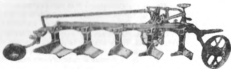
Рис. 29. Плуг-лушильник пятикорпусный ПЛ-5-25
